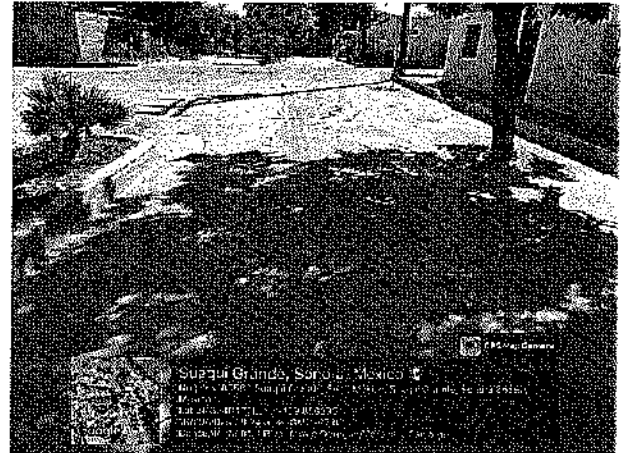
Reposición de pavimento de concreto de f_c = 200 \text{ kg/cm}^2 , t.m.a. 3/4" de diámetro hecho en obra, de 0.15 m. de espesor.
